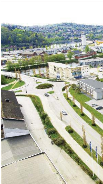
IKKE LENGRE BRAKK: Leilighetsbygget nærmest elva er snart ferdig, mens de første bygget til våren 2013.
